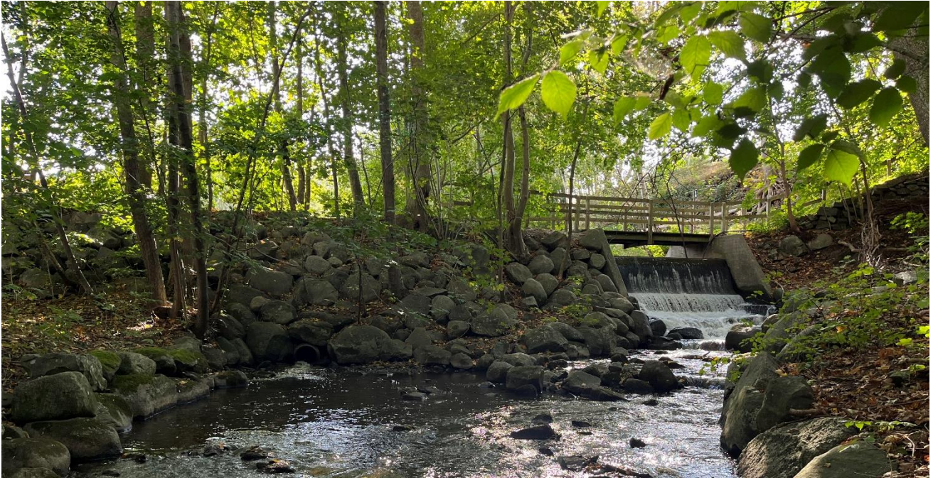
Figur 5. Nedströmssidan av överfallsutskovet (till höger i bild) och bräddavloppets utlopp (Norconsult, oktober 2023).
