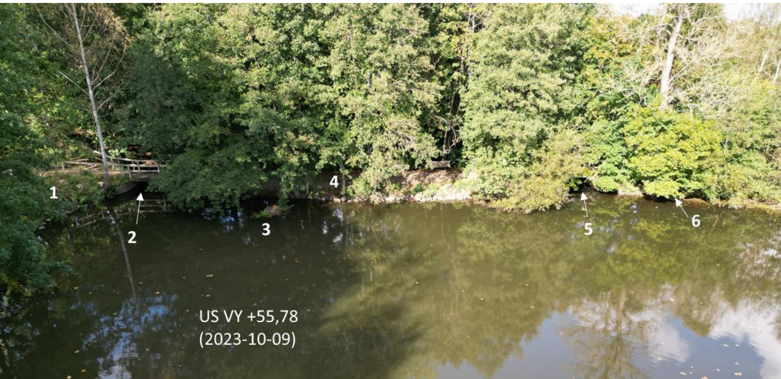
Figur 4. Mölledammen i medströmsriktning (Norconsult, oktober 2023). Uppströms vattenyta uppmättes till +55,78 den 9:e oktober 2023.
