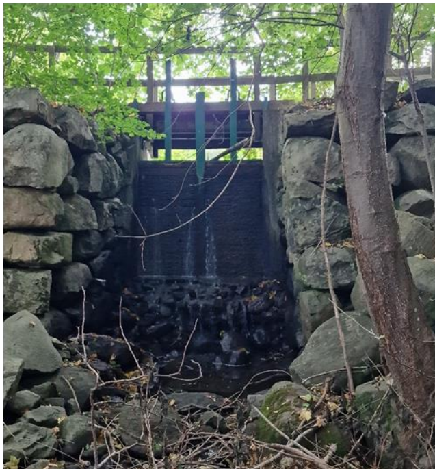
Figur 6. Till vänster: Nedströmssidan av spettutskovet. Till höger: Bräddavloppet med skyddsgaller. (Norconsult, oktober 2023)
