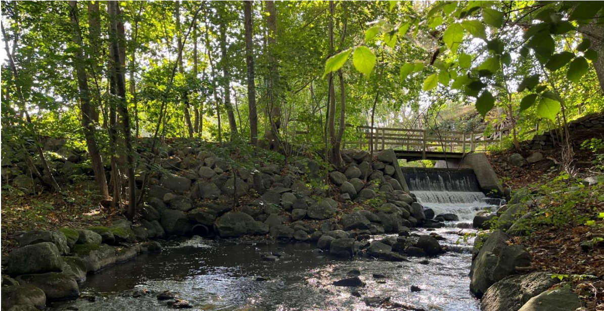
Figur 5-10. Nedströmssidan av dammvallen med överfallsutskovet längst till höger i bilden och bräddavloppets utlopp längst till vänster i vattenområdet.
