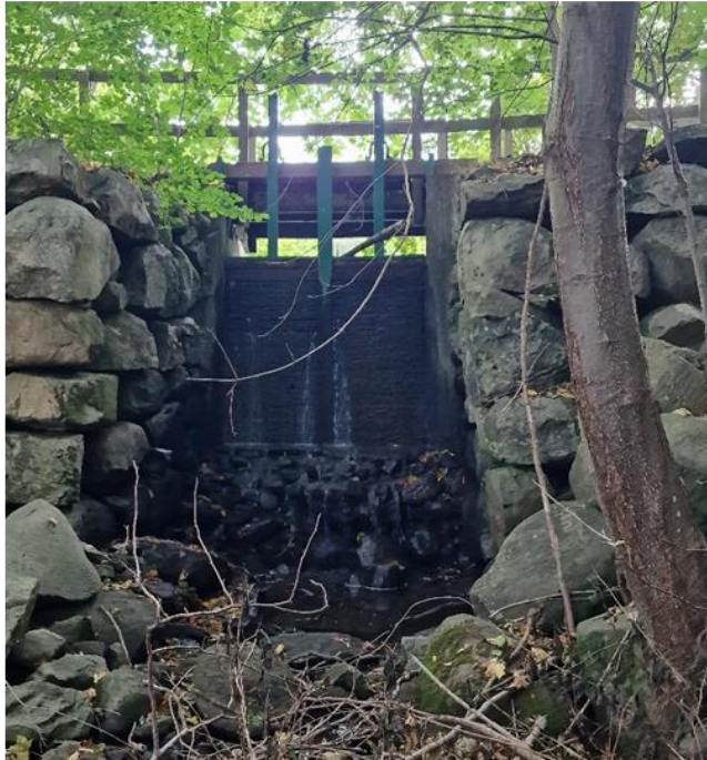
Figur 5-11. Till vänster: Nedströmssidan av spettutskovet. Till höger: Bräddavloppet med skyddsgaller.
