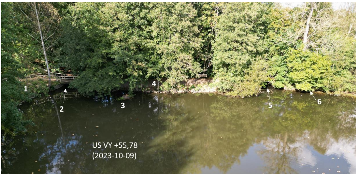
Figur 5-9. Ingående delar i befintlig anläggning.
